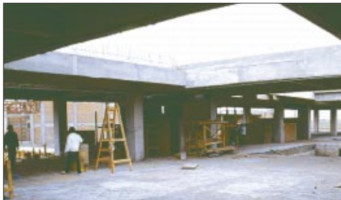
Le chantier de construction : bâtiment pédagogique
